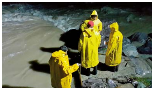
Limpieza de la Obra de Toma Rincón de la Vitoria
