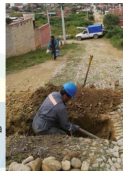
Renovación Acometida de Agua Potable B° Carlos Wagner
