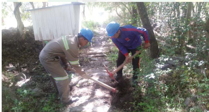
Mantenimiento Tapas Canal de Aducción Rincón de La Vitoria
