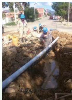
Renovación Red de Agua Potable B° San Bernardo
