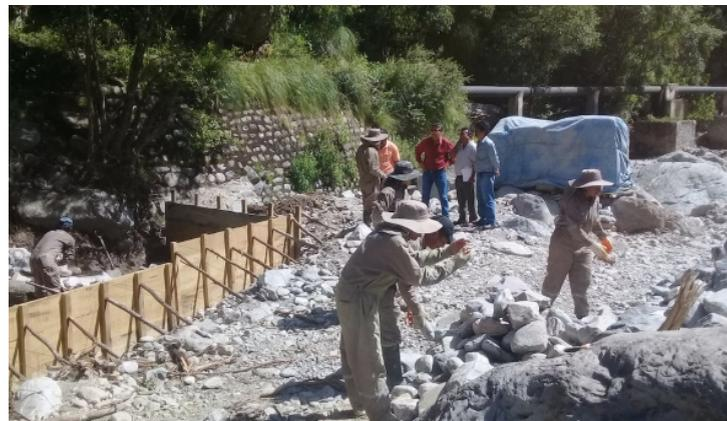
Construcción de Muro de Hormigón Ciclópeo para protección de tubería Rincón de la Victoria
