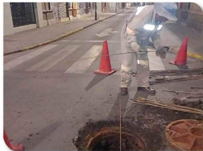
Mantenimiento de la red de alcantarillado sanitario
