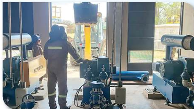
Mantenimiento del soplador C, PTAR San Blas.
