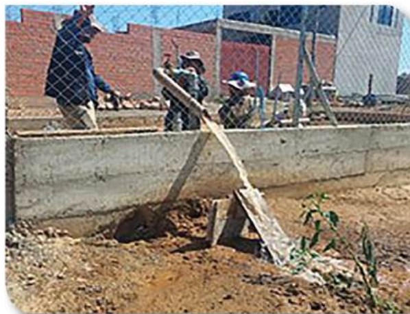
Habilitación del pozo barrio 6 de Abril.
